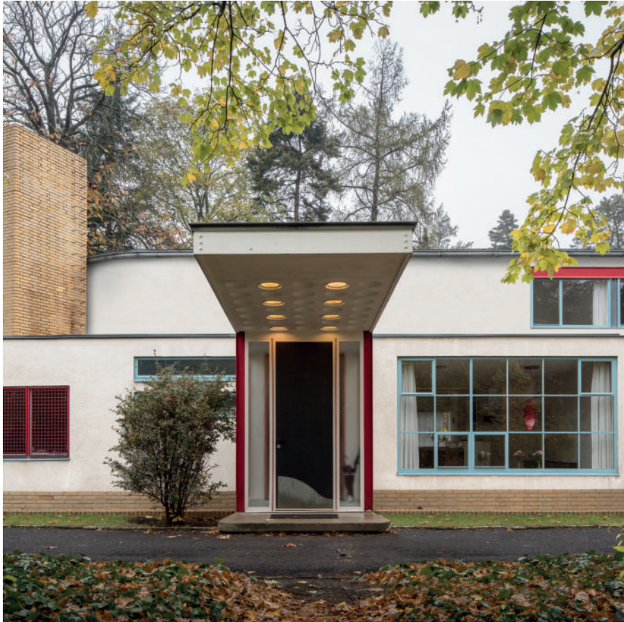
Eingangstür Front door
