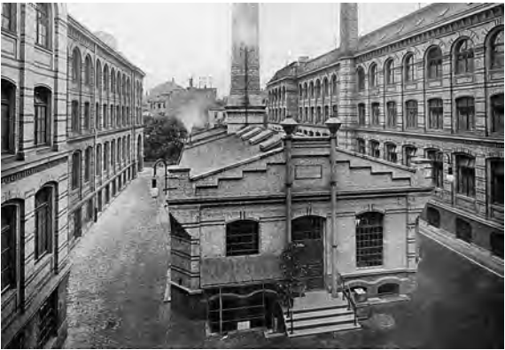
Innenhof mit Maschinenhaus
