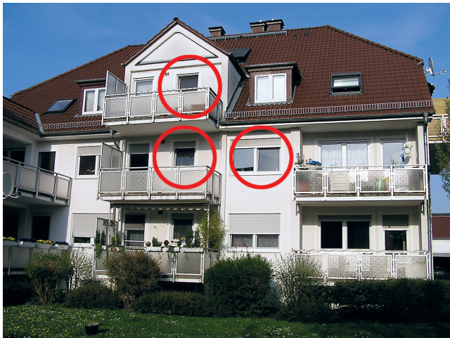
Bild 2 Erkundung erreichbarer Zugänge an der Gebäuderückseite
