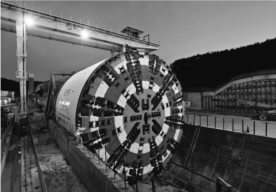
Bild 1.1 Baustellenmontage des Erd-druckschildes für den Sparvo-Straßentunnel in Italien mit ca. 15,55 m Durchmesser (Foto: Herrenknecht AG)
