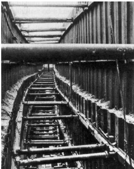
Bild 1.5 Senkrechter Grabenverbau mit gestaffelten Kanaldielen (Foto: Hoesch AG, Dortmund)
