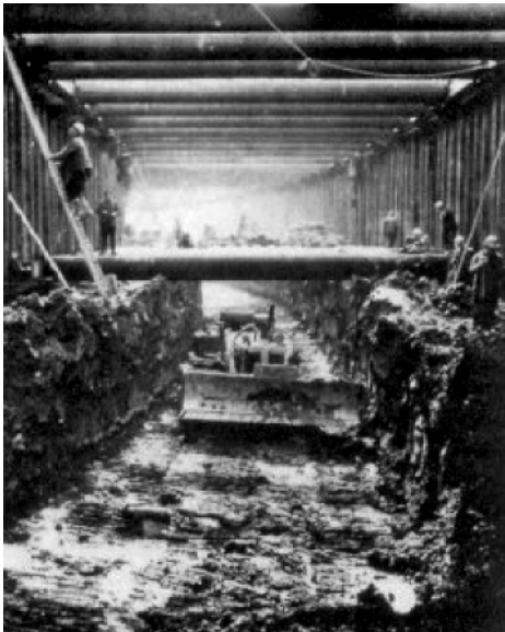
Bild 1.16 Abgespundete Tunnelbaugrube; City-S-Bahn Hamburg, Baulos Binnentalster (Foto: Bundesbahndirektion Hamburg)
