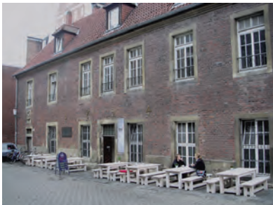
Remise der früheren Dompropstei, 1724
