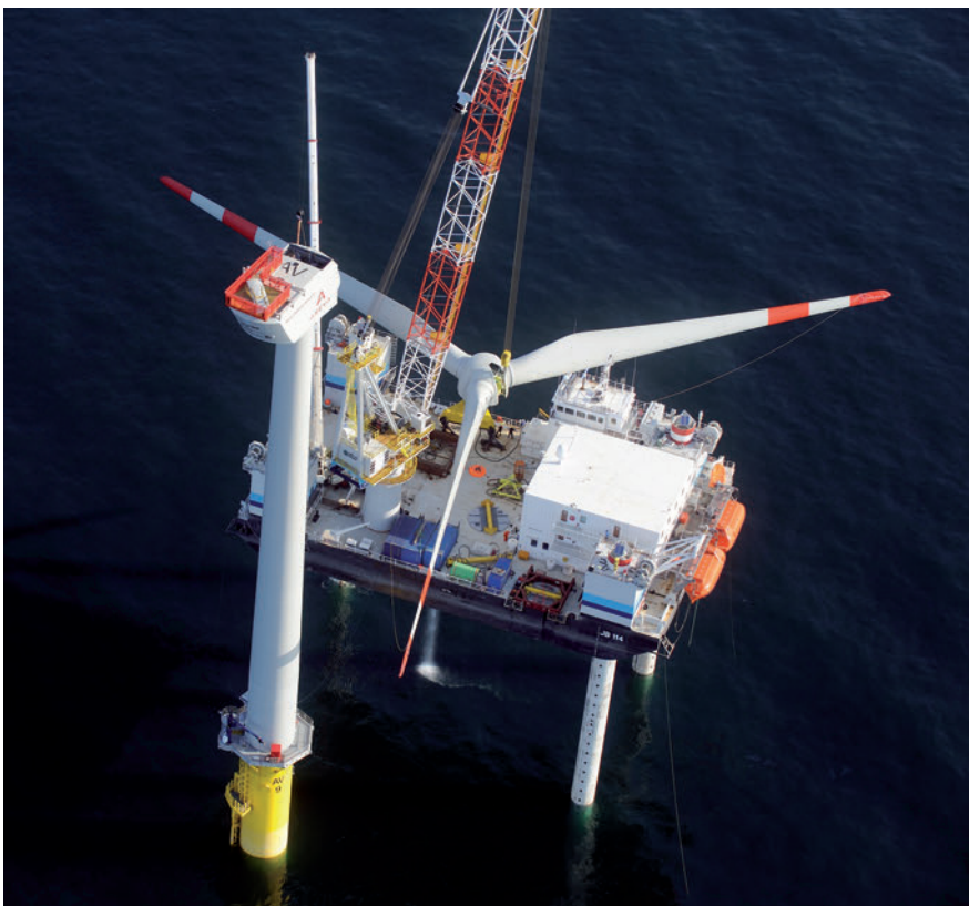
Abb. 6.1 ► Montage einer Windkraftanlage im Windpark Alpha Ventus
