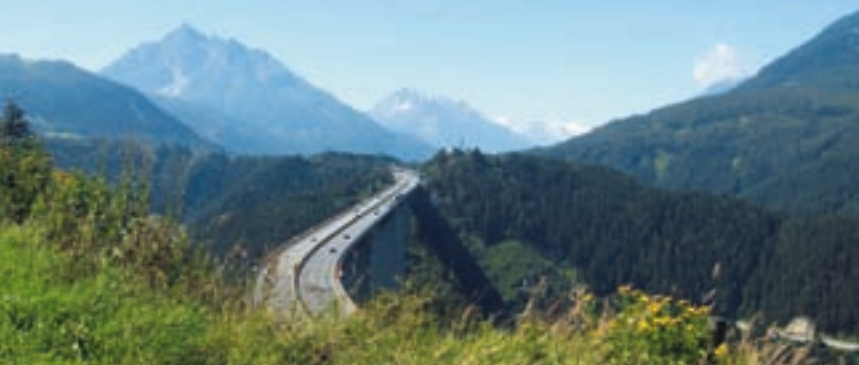
Die Europabrücke – Kernstück der Brennerautobahn
