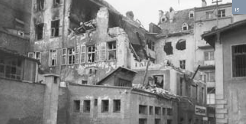
Kriegsschäden in Innsbruck (Sparkassenplatz)
