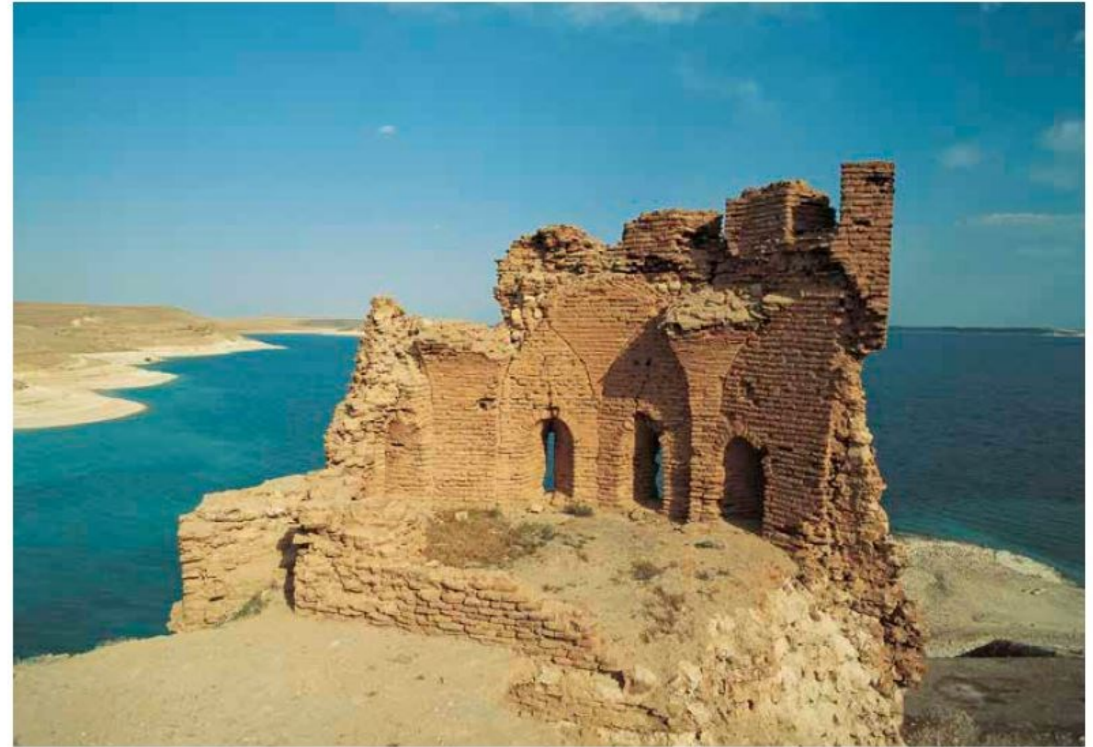
Eine Besonderheit, die Qal'at Dja'bar von allen anderen syrischen Burgen unterscheidet, ist die ausschließliche Verwendung von Ziegelsteinen, die bezeugt, dass die Zitadelle am einstigen Euphratufer (heute Assad-Stausee) ganz in mesopotamischer Tradition steht.
