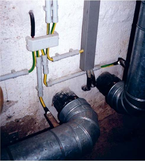
**Bild 5.159** Potentialausgleichsschiene am Gebäudeeintritt
