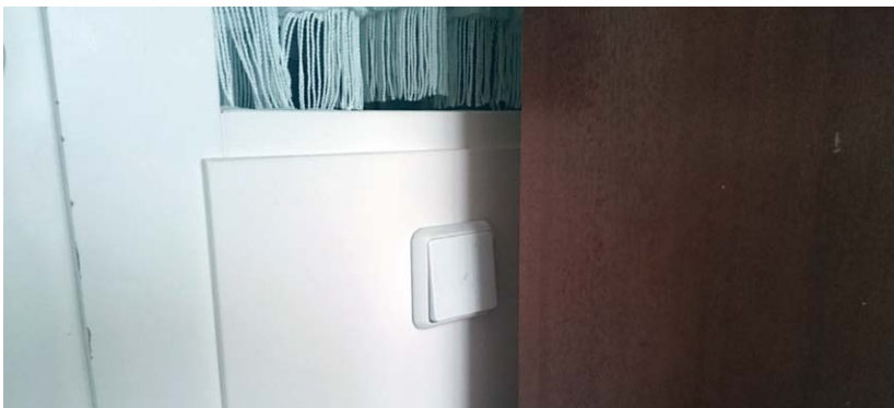
Abb. 9.1: Beispiel eines schlecht erreichbaren Lichtschalters
