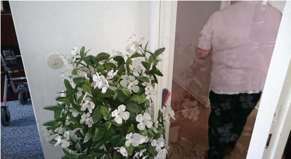
Abb. 9.2: Beispiel eines Schalters, der zu weit von der Zimmertür entfernt ist
