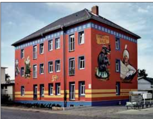
Bild 2: SARRASANI-Haus in Radebeul bei Dresden
