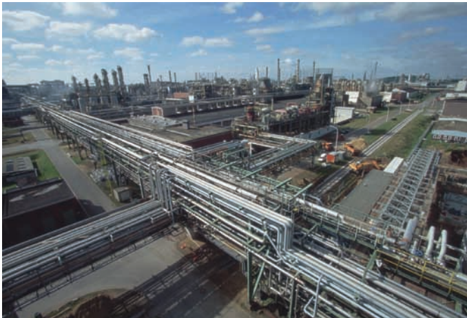
Abbildung 1-1 Rohrleitungen im Chemiepark Marl
