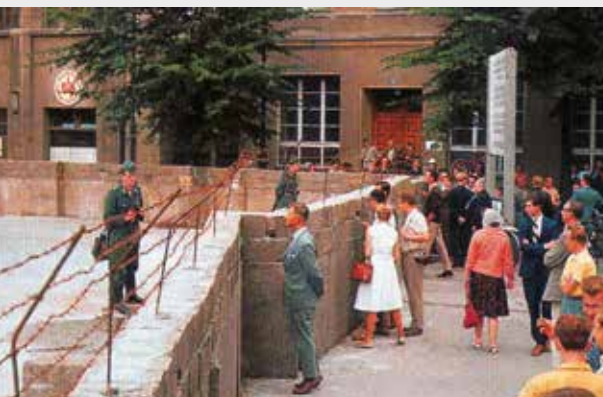
Bau der Mauer in Neukölln.
