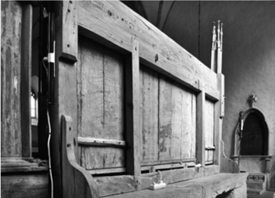
1. Rückseite des Retabels mit jüngerer Rahmenkonstruktion
