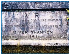
Roosky Lock wurde 1848 in der heutigen Form errichtet.
