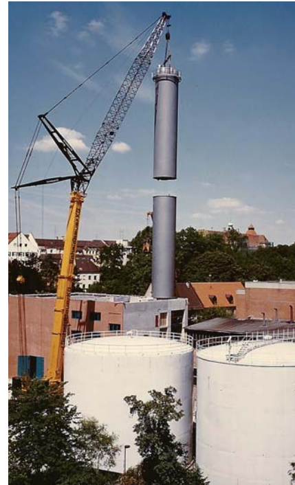
Ein neuer Abgaskamin hängt am Kranhaken. Die beiden weißen Tanks deuten auf die beendete Kohle- und Kokszeit im Heizkraftwerk.
