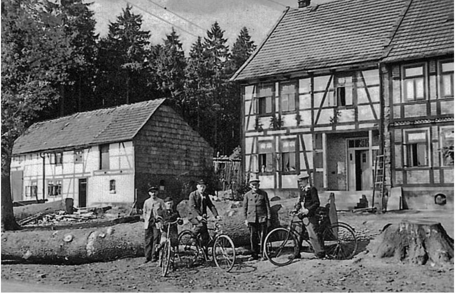
Umbau Haus Melching 1935 (heute Gastwirtschaft)
