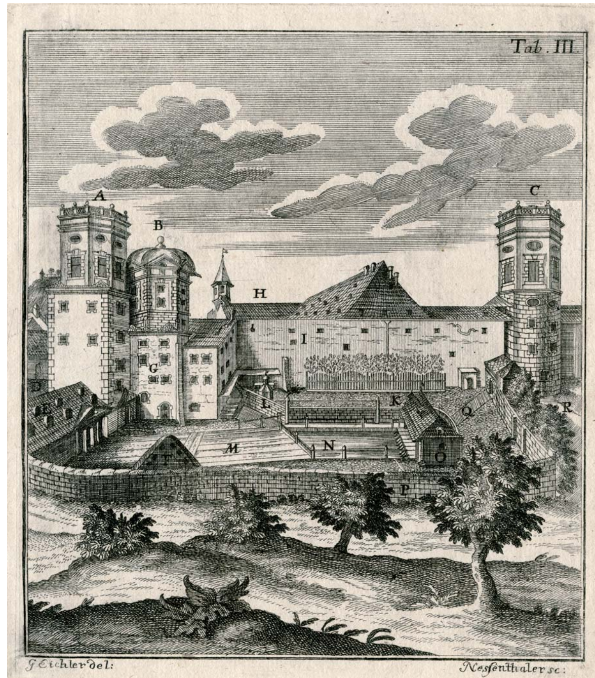
Das Obere Wasserwerk am Roten Tor nach seiner Erneuerung in den Jahren 1742 und 1743 durch den Brunnenmeister der Reichsstadt Augsburg, Caspar Walter. Nach einer Zeichnung des Stadtbrunnenmeisters entstand dieser Stich der Ostansicht des ältesten und größten Augsburger Wasserwerks, das in der Zeit von 1416/34 bis 1879 in Betrieb war. Abgedruckt wurde das Motiv in Walters 1766 in Augsburg erschienenem Werk „Anweisung vor einen jederweiligen Stadt=Brunnen=Meister in der des Heil. Röm. Reichs=Stadt Augspurg [...]“.
