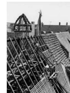
Wiederaufbau des Alten Rathauses, Marktseite während der Dachdecker- arbeiten mit Richtkrone, 28. Mai 1947
