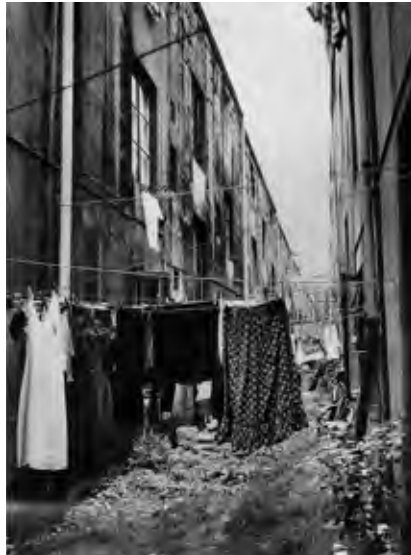
Oben: Arbeitermietkasernen in Hamburg, Foto, o. J.
