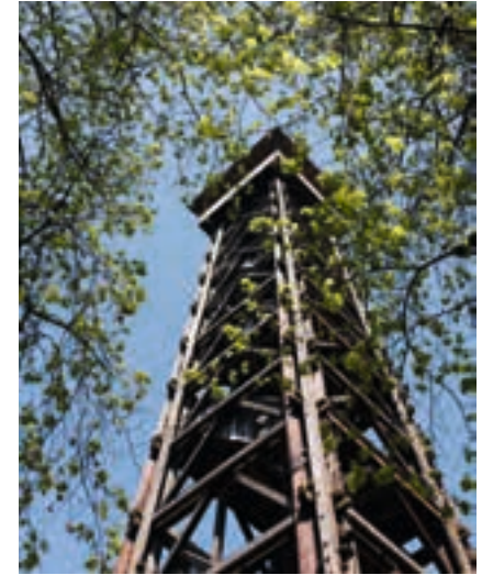
Im Oktober 2017 wurde der Goethe-Turm durch Brandstiftung zerstört.
