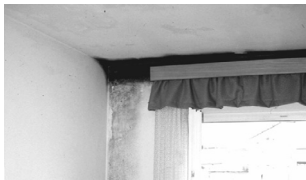
fig. 1.3 Muffa su una superficie interna (Foto: Peter Erlacher, 1995)
